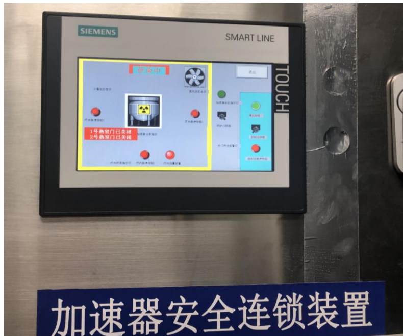
图 4-10 加速器安全连锁装置示意图
