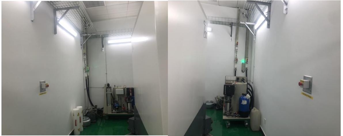
图 4-15 加速器控制室及其大厅急停按钮（红色按钮）位置现场照片
