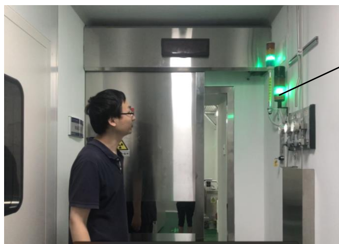
图 4-11 加速器防护门打开时门口现场照片
