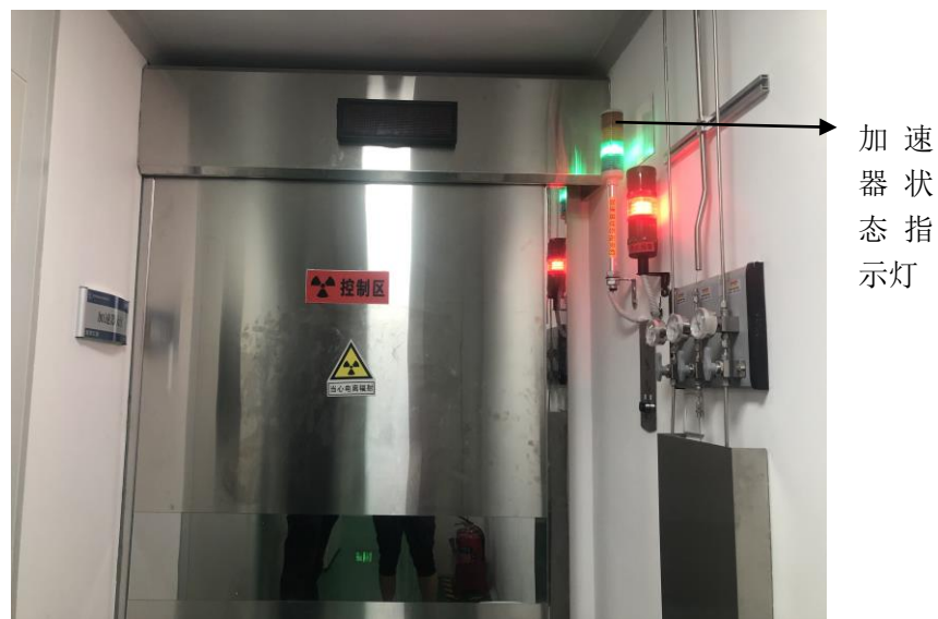
图 4-13 防护门外加速器联锁指示灯设置现场照片
